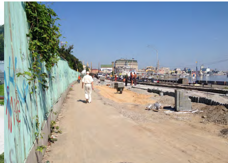
Вигляд до реконструкції
