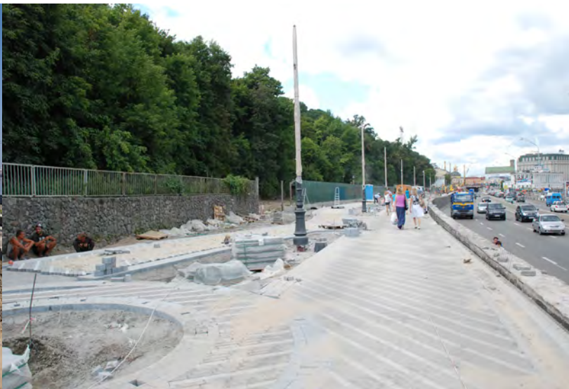
Вигляд в процесі реконструкції
