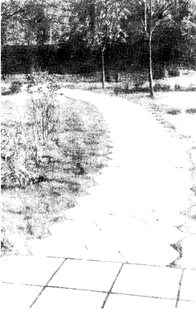
Рис. 128. Дорожка, мощенная плитами из песчаного бетона
