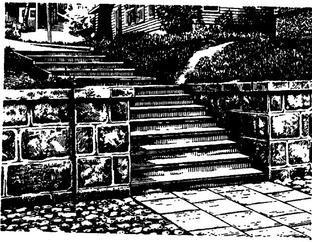
Рис. 21. Архитектурно-декоративное оформление подпорной стенки
